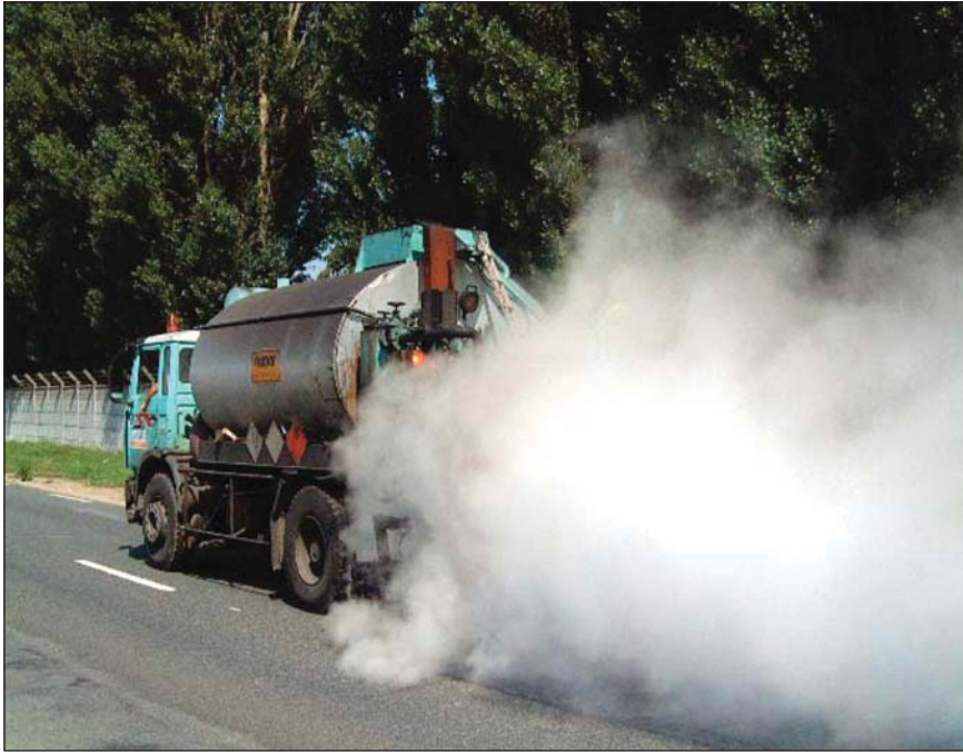
Figure 2. Réalisation d'un enduit utilisant un liant pétrofluxé.
