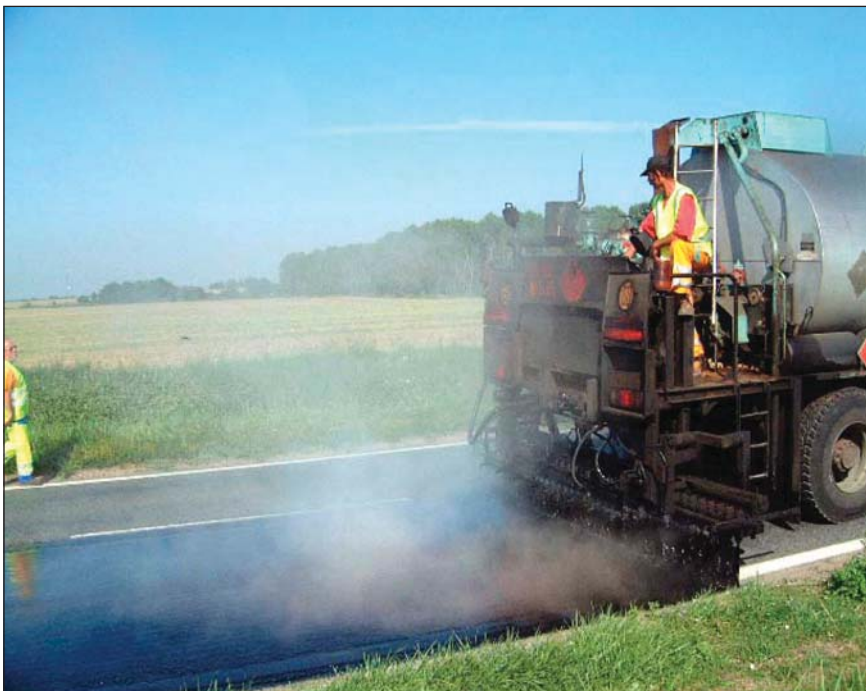
Figure 3. Réalisation d'un enduit utilisant un liant biofluxé.
