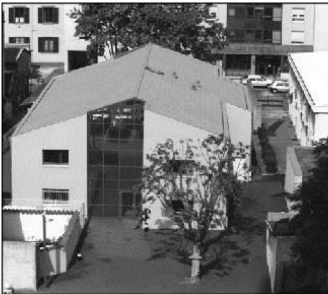
Figure 11 Bâtiment de stockage des cuves (IARC, Lyon).
