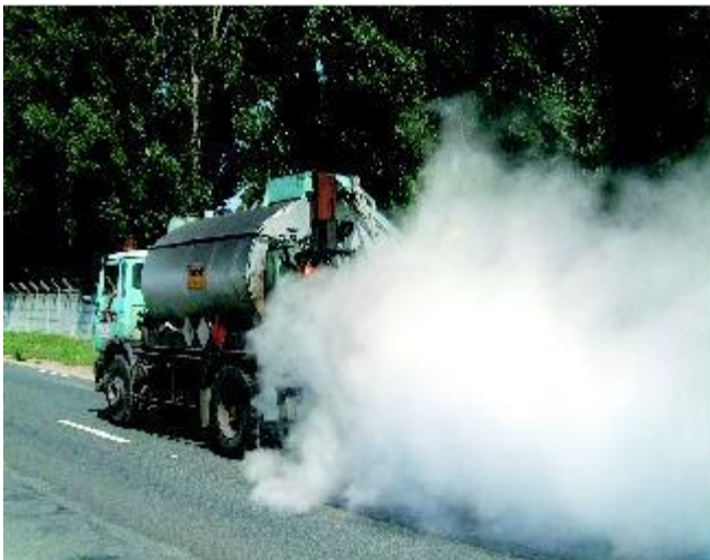
Photo 1. Réalisation d'un chantier pétrofluxé.
